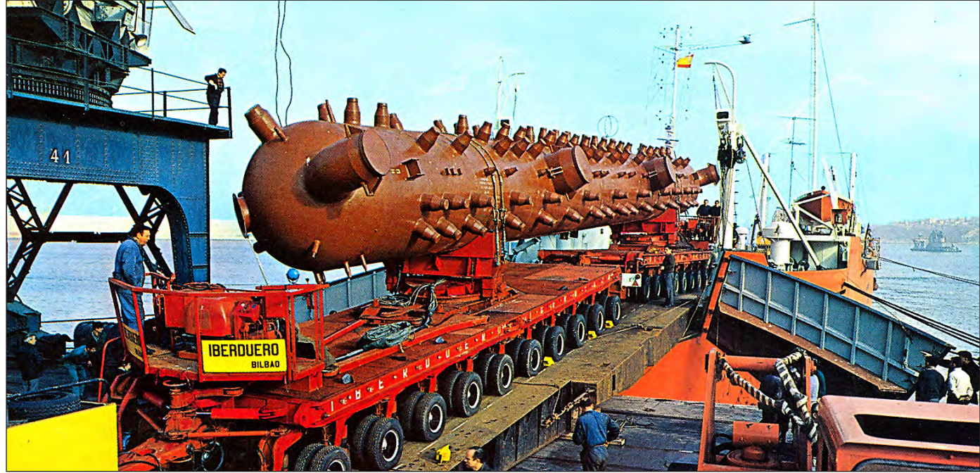
Tambor de 330 Tm de peso construido por Babcock&Wilcox (Sestao) con destino a la caldera del grupo II, de 540 MW de potencia de la Central Térmica de Santurce (Iberduero) 1970. AHBBVA.
