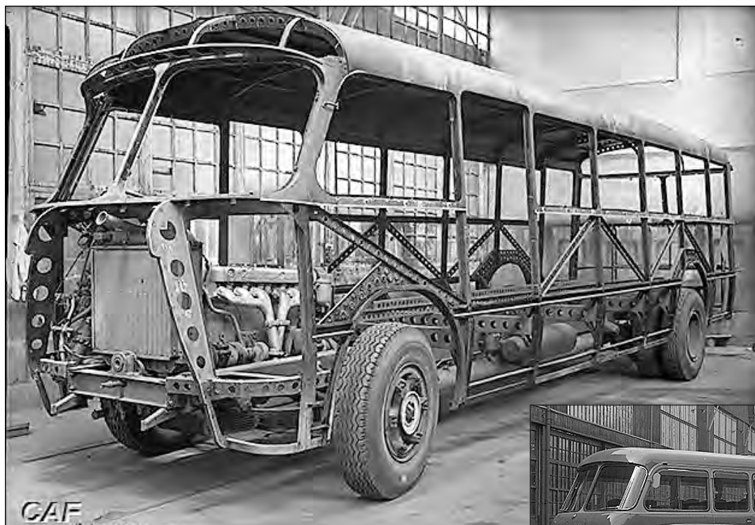
Autocar Pegaso II con armazón metálico soldado. CAF 1954.
