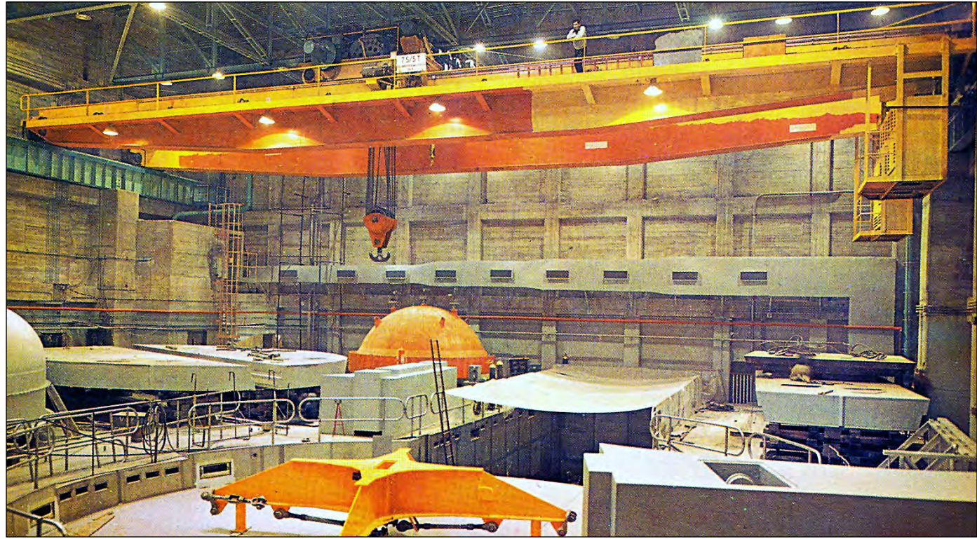
Babcock & Wilcox (Sestao). Grúa puente para el manejo del reactor de la C.N. de Santa María de Garoña. NUCLENOR (Burgos, 1970) AHBVA.
