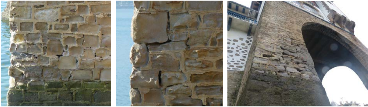
Figura 5: Aspecto de la arenisca y de los morteros en la zona de carrera de mareas.
