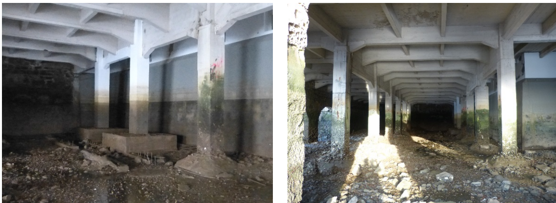
Figura 6: a) Pilares en carrera de mareas y zapatas reconstruidas delante del muro de hormigón de refuerzo del edificio preexistente; b) esquema estructural del forjado de planta baja
