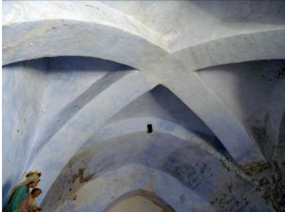
Figura 7: Bóveda de crucería en el ábside
