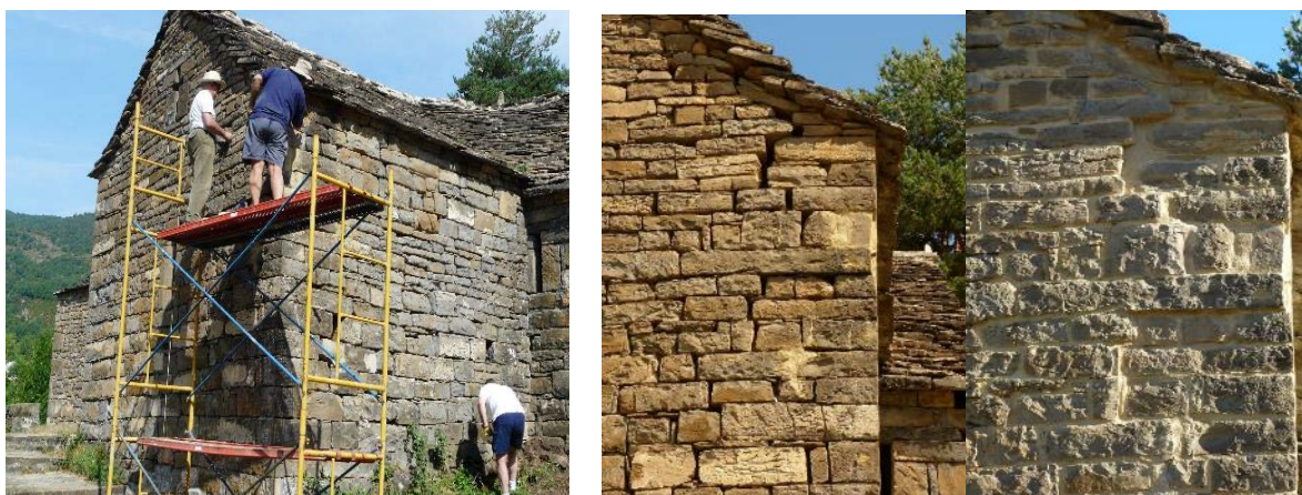
Figura 11: Trabajos de consolidación estructural.
