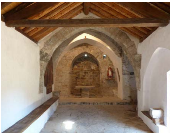
Figura 15: Vista hacia el presbiterio de la ermita tras la terminación de la restauración.
