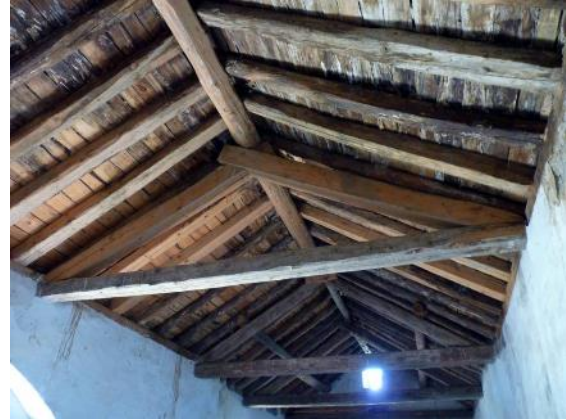
Figura 8: Cubierta del cuerpo de la nave principal
