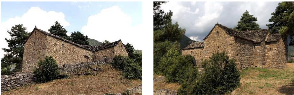
Figura 4: Fachadas Oeste y Sur, y fachadas Sur y Este.
