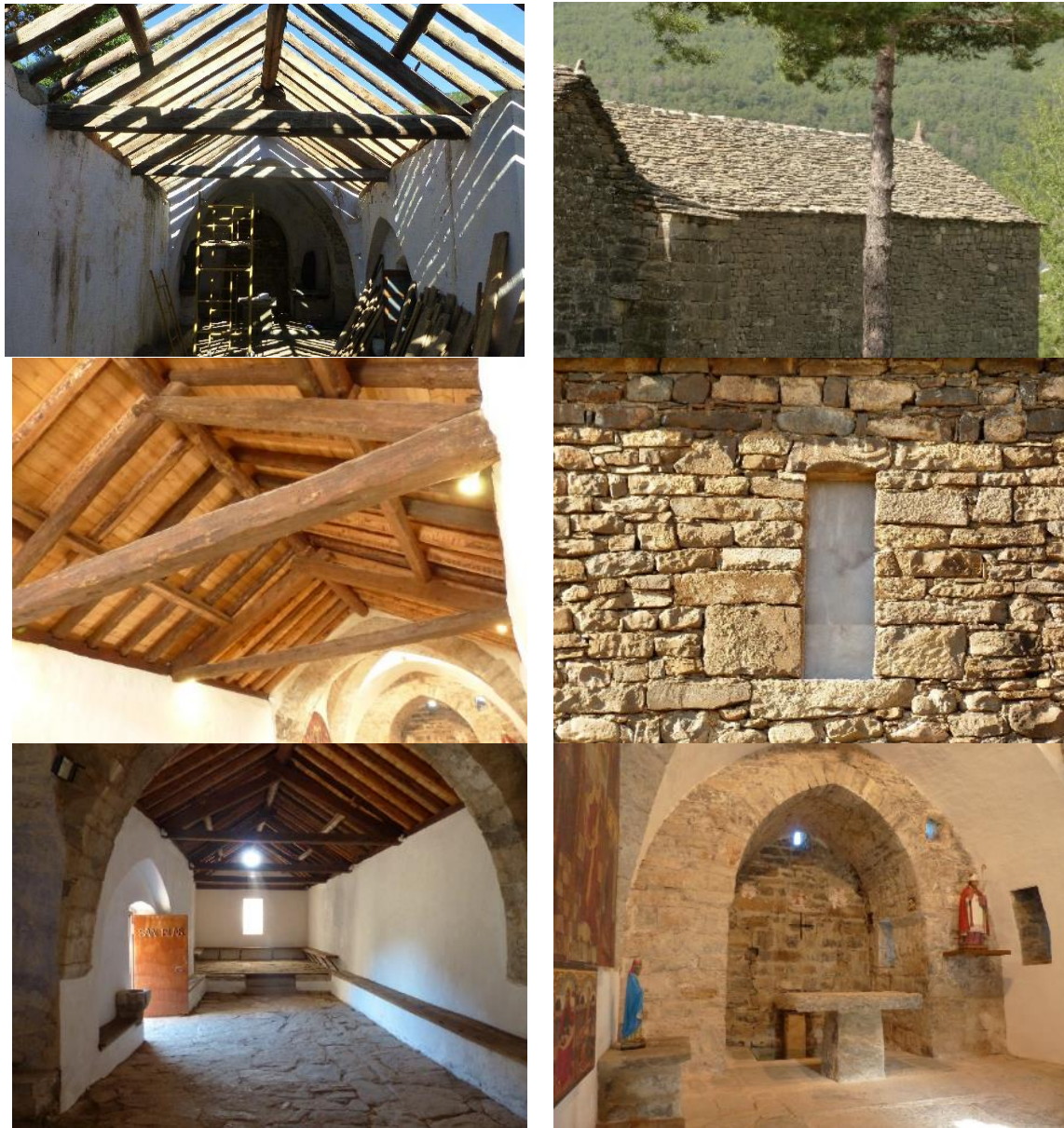
Figura 12: Trabajos del verano de 2013.
