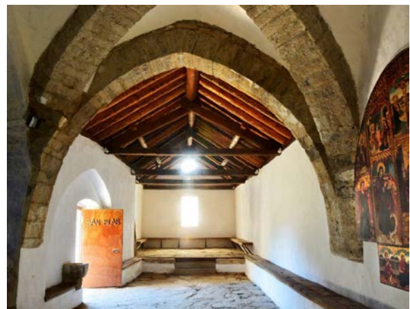
Figura 16: Vista de la nave principal de la ermita tras la restauración.
