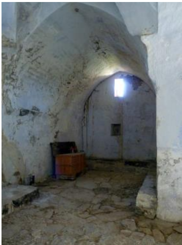
Figura 9: Vista del brazo Sur
