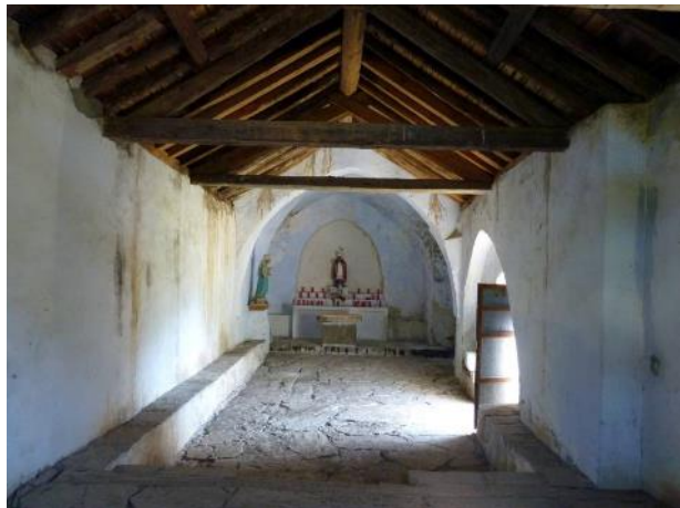
Figura 10: Vista general del interior
