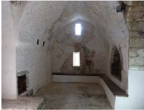
Figura 17: Vista de la capilla Floral tras la restauración.
