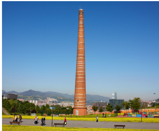
Figura 1: Chimenea de Etxebarria, vista de estado actual.
