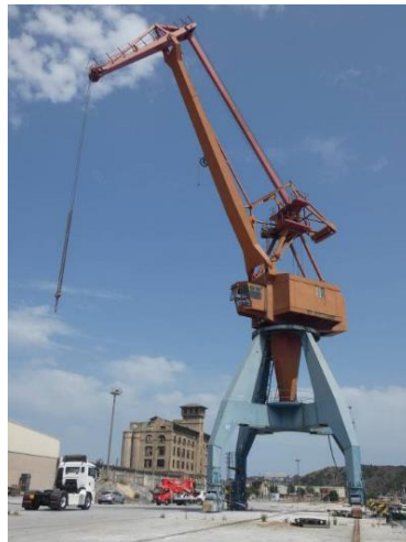
Figura 5: Imagen actual de la grúa nº 67, detrás el edificio de Molinos Vascos.
