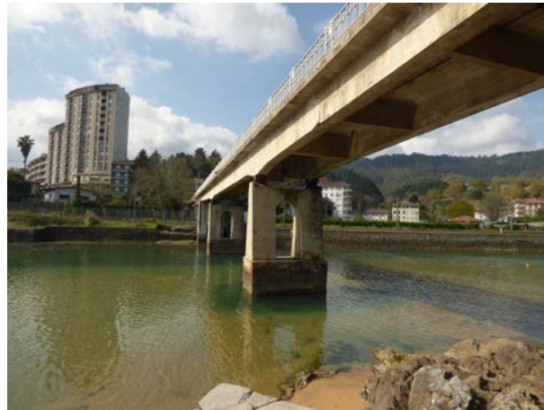
Figura 1: Vista general del puente de Txatxarramendi. Estado actual.
