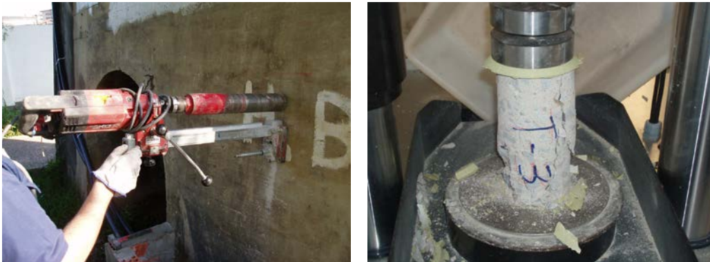
Figura 4: Extracción y rotura a compresión de testigo de hormigón.
