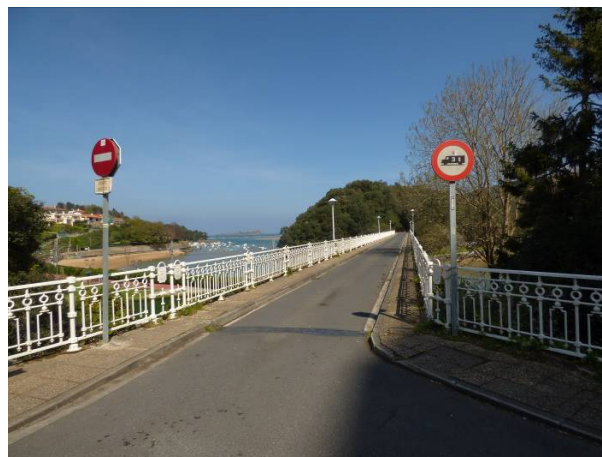
Figura 9: Señal de prohibición de paso de vehículos de carga mayor a 3 t colocada en la cara superior del puente.
