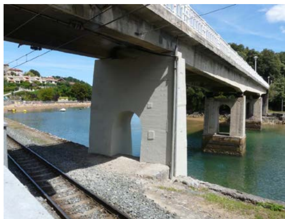
Figura 7: Estado final de la pila 3 tras la rehabilitación realizada en 2013.
