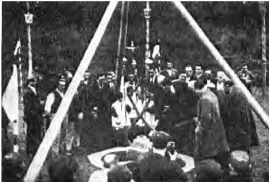
Alcalde y concejales en la colocación de la primera piedra de las obras de abastecimiento de aguas de Ordunte. 1926. (Boletín de Estadística del Ayuntamiento de Bilbao)
