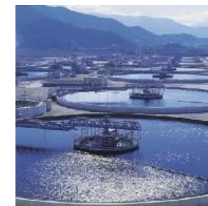
Uren tratamendua Tratamiento de aguas
