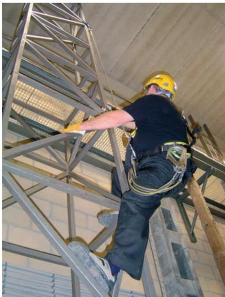
Se utilizaran cuando los tránsitos por las escaleras sean frecuentes, y no existan líneas fijas instaladas. Se instalarán por ejemplo, mediante el sistema de progresión de doble cabo y realizando una de las cabeceras de línea explicada anteriormente. Este tipo de sistemas este fabricado normalmente con cuerdas de poliamida, tanto trenzada como con funda. Cumplen con la norma UNE-EN-353/2.
