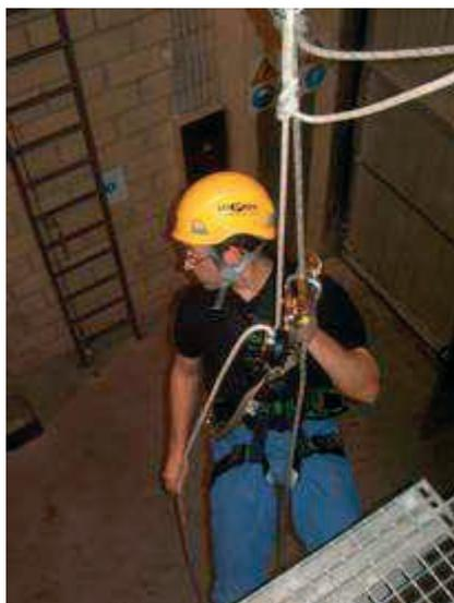
El sistema constará como mínimo de dos cuerdas de sujeción independientes, una como medio de acceso, de descenso y de apoyo (línea de trabajo) y la otra como medio de emergencia (línea de vida o seguridad). En caso de izado, descenso o sujeción de cargas se utilizara una tercera cuerda.
